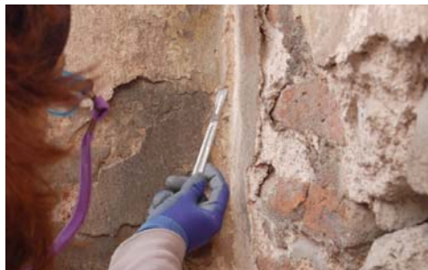
Picture 13. Sampling the plaster Resim 13. Siva numunesi alımı
