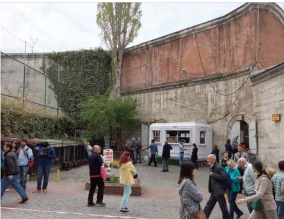
Picture 4. Restoration works at Nuru Osmaniye Complex Resim 4 Nuru Osmaniye Külliyesi'ndeki restorasyon çalışmaları
