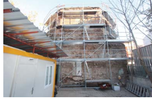
Picture 14. East façade scaffold Resim 14. Doğu cephesi iskelesi
