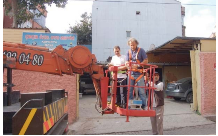
Picture 2. The crane used for the total scan of the façade Resim 2. Cephenin tamamen taranabilmesi için kullanılan vinç
