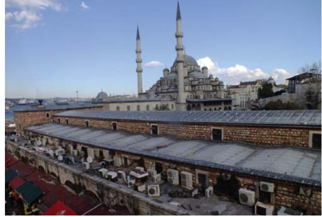
Picture 4. Spice Bazaar before the repair works Resim 4. Onarım öncesi Mısır Çarşısı
