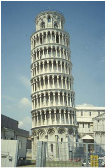
Picture 23. The leaning Tower of Pisa Resim 23. Eğilen Pisa Kulesi
