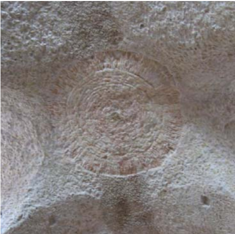
Picture 2. The oculus after restoration works Resim 2. Restorasyon çalışmalarından sonra oculus
