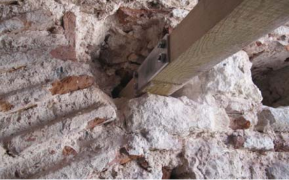
Picture 9. Repairment of the wooden jambs Resim 9. Ahşap hatıl onarımı
