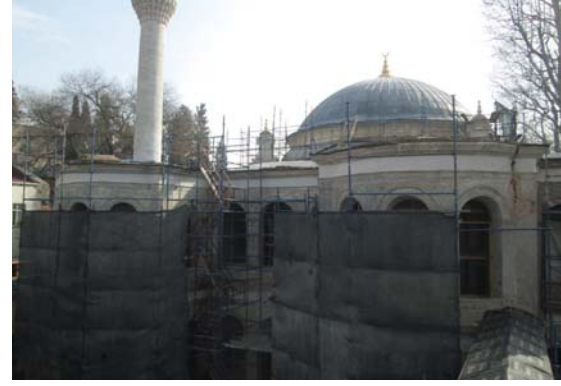
Picture 24. General view after consolidation (K. Mecidiye Mosque – 2014) Resim 24. Güçlendirme uygulaması sonrasında genel görünüş (K.Mecidiye Camii 2014)
