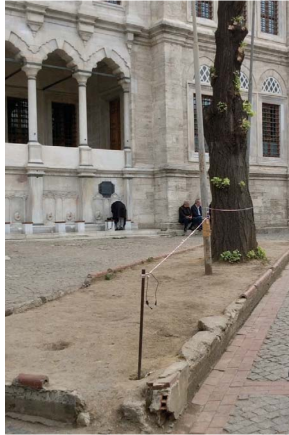
Picture 5. Restoration works at Nuru Osmaniye Complex Resim 5. Nuru Osmaniye Külliyesi'ndeki restorasyon çalışmaları
