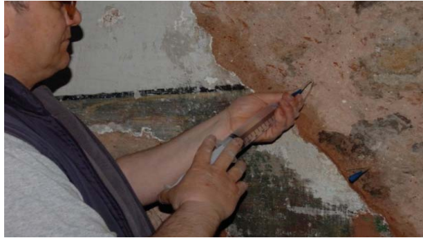
Picture 48. Microinjection on the walls Resim 48. Duvarlarda mikro enjeksiyon çalışması yapılması
