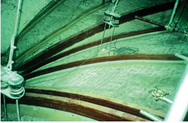
Picture 21. The Basilica of St. Francis in Assisi: Timber strips forming the ribs Resim 21. Assisi'deki St. Francis Bazilikası: Nervürleri oluşturan kereste şeritler
