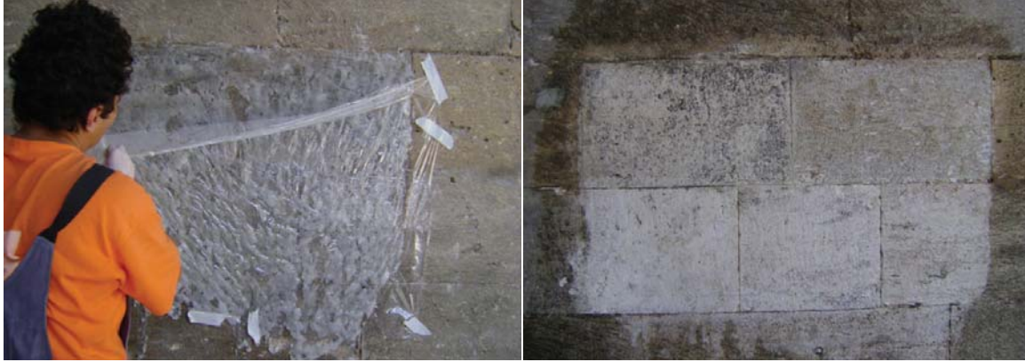
Picture 11. Chemical cleaning application being applied on limestone wall surface for testing purpose and its result Resim 11. Küfeki taş duvar yüzeyinde test amaçlı yapılmış olan kimyasal temizlik uygulaması ve sonucu
