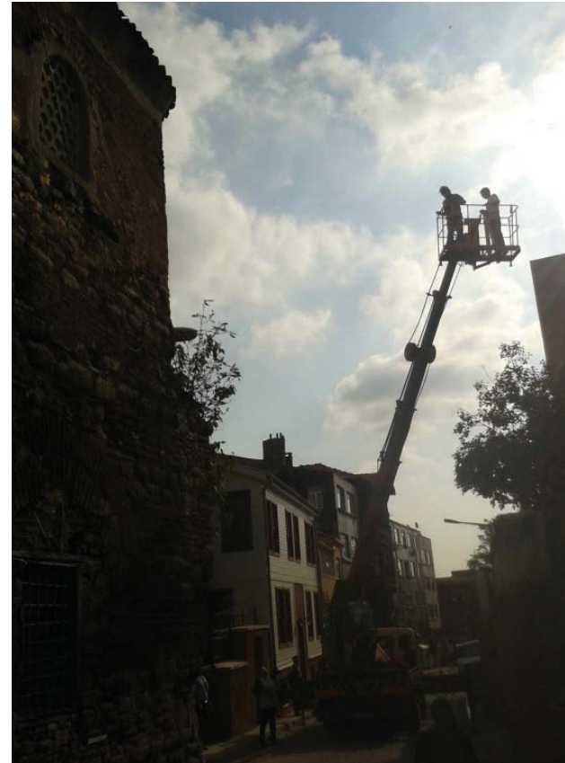
Picture 7. Implementation project: laser scanner survey Resim 7. Uygulama projesi: lazer tarayıcı araştırması
