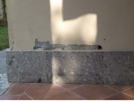
Picture 1. Covering/waterproofing Resim 1. Kaplama/su geçirmezlik sağlanması
