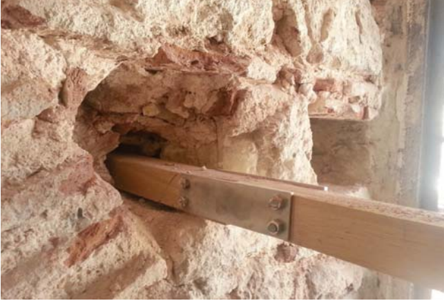
Picture 33. Mısır Çarşısı (Spice Bazaar) vault plinth in-wall horizontal beam implementation (2014)
