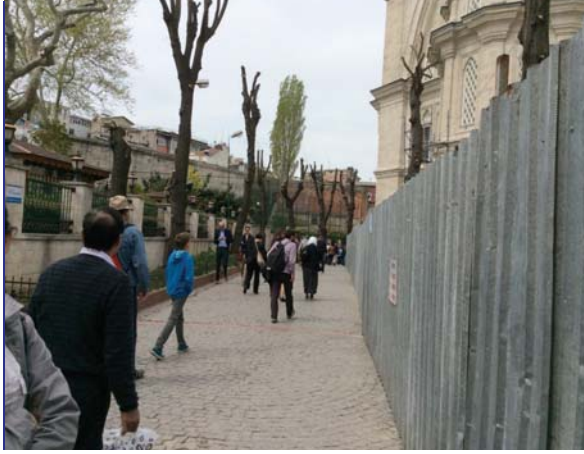
Picture 2. Restoration works at Nuru Osmaniye Complex Resim 2. Nuru Osmaniye Külliyesi'ndeki restorasyon çalışmaları
