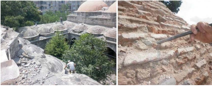
Picture 10. Removal of cement plaster on the domes (E. Sünnetçi, 2010) Resim 10. Kubbelerde çimento harcın kaldırılması (E. Sünnetçi, 2010)
