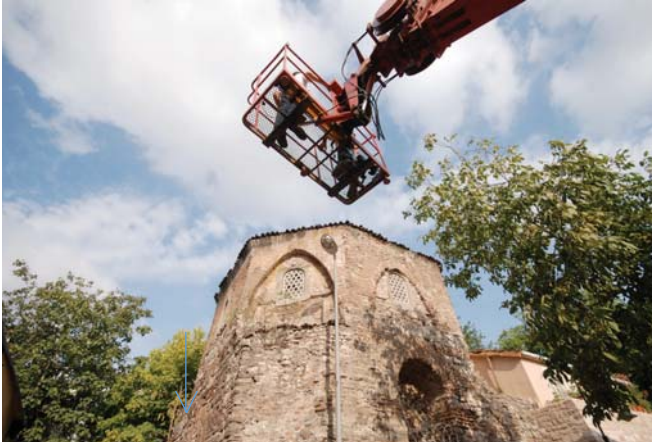
Picture 1. Laser scanning of the façade Resim 1. Cephede lazer tarama çalışması
