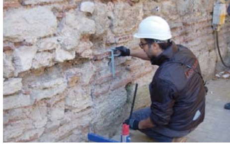
Picture 10. Material analysis Resim 10. Malzeme analiz çalışmaları
