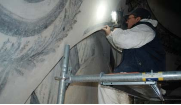
Picture 43. During the scraping Resim 43. Badana raspası yapılırken
