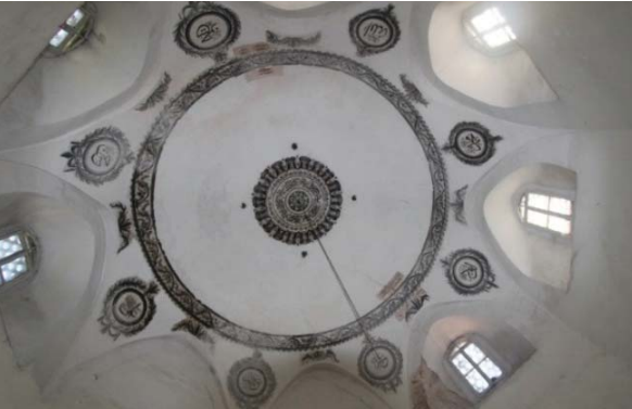
Picture 35. Inside view of the dome Resim 35. Kubbeye içten bakış
