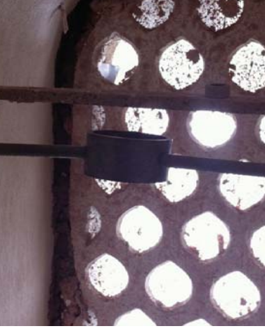
Picture 44. Beyazıt Camii ana kubbe kasnağı yeni gergi uygulama detayı (2013)
