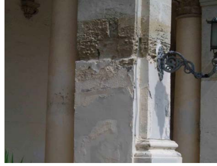
Picture 2. Waterproof linings Resim 2. Su geçirmez astarlama
